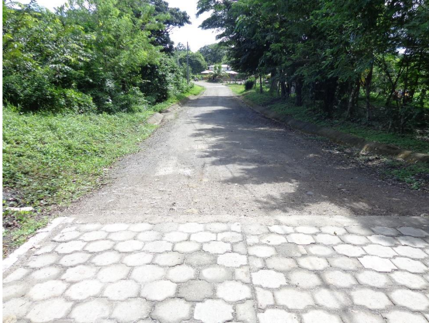
Estado Actual del Tramo
