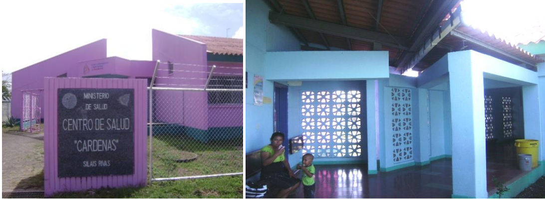
Figura N° 29 y 30: Vista exterior e interior del Centro de Salud. Foto MAC, Febrero 2011.
