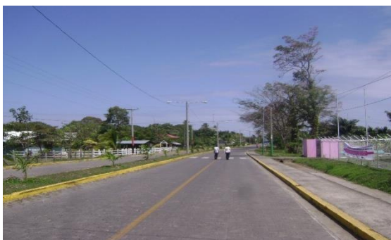
Figura Nº 2: Entrada al poblado de Cárdenas, Puede notarse la limpieza, alumbrado público y el ornato. Fecha Febrero 2011, Foto MAC.
